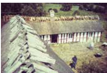
Korsvirkeshus. Bristen på ek gjorde att man ersatte skiftesverkshusens grova, liggande ekplankor mellan stolparna med lera.
