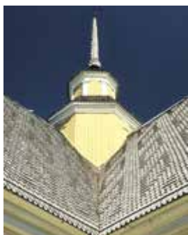
Aspved står emot fukt väl och användes ofta till takspån.
